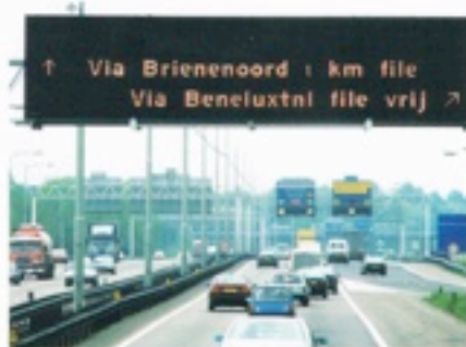
Dynamische Route Informatie Panelen (DRIPs) geven objectieve, actuele en betrouwbare informatie aan de weggebruikers.
